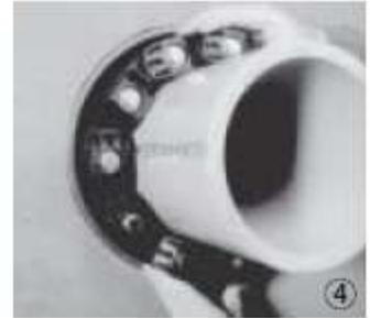
Centrer le tube ou le câble à l'intérieur de l'ouverture, vérifier que le tube est correctement supporté à chaque extrémité. Le Link Seal® est un système d'étanchéité et n'est pas conçu pour supporter le poids de la tuyauterie.
